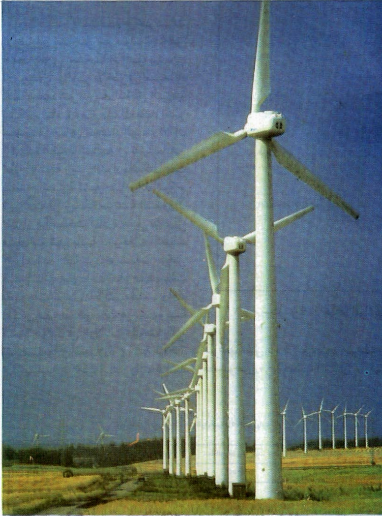
شكل ( 3 ) المزرعة الريحية الموجودة في الدنمارك بقدرة 3.8 ميجاوات وتضم 21 منظومة تحويل بقدرة 180 ك. و ات
