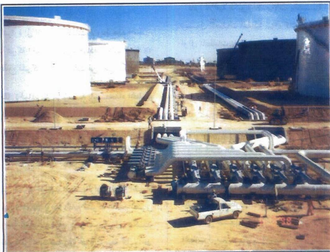
منها منظومة لإطفاء الحرائق، منظومة أجهزة القياس، كما تحتوي على غرفة تحكم ومنظومة ضخ تتكون من عدد 5 مضخات قوة كل منها 150,000 برميل يومياً، كما تتكون الحظيرة من محطة توزيع للكهرباء متكاملة ومنظومة للهواء المضغوط ومولد كهرباء احتياطي. ويوجد بالحظيرة محطة لاستقبال المياه الملوثة بالنفط التي تجمعت بقاع الخزانات حيث يتم فصل النقط عن الماء حتى نسبة تركيز تصل إلى "5" أجزاء من المليون ومنها يتم تحويل المياه المنقاة إلى حوض بالمياه داخل الحظيرة.
